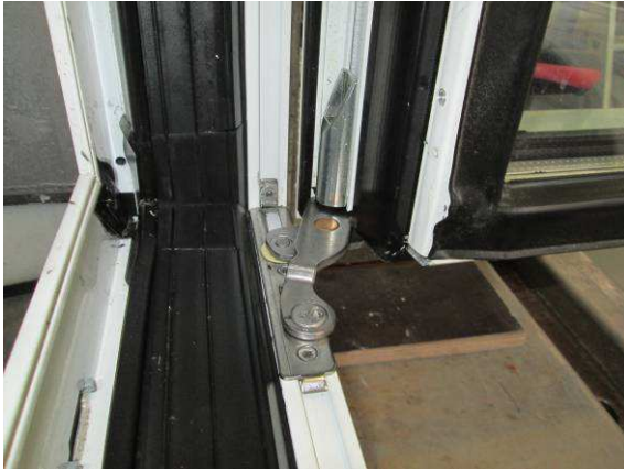
Bild 5 Ecklager, Falzansicht
