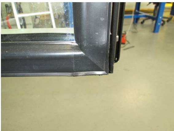
Bild 4 Äußere Verglasungsdichtung, Eckausbildung
