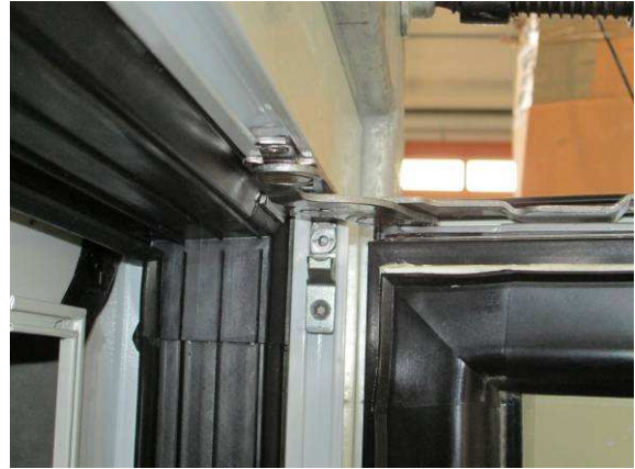
Bild 6 Scherenlager, Falzansicht
