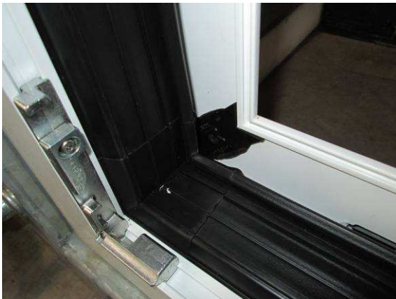
Bild 2 Mitteldichtung, Eckausbildung
