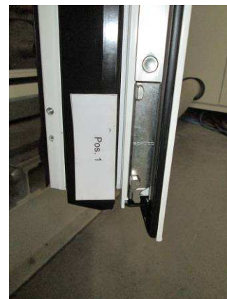
Bild 10 Verriegelungssituation Flügelrahmen, Pos. 1
