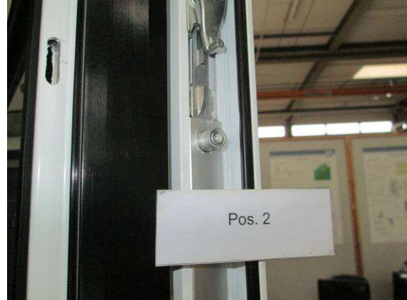
Bild 12 Verriegelungssituation Flügelrahmen, Pos. 2
