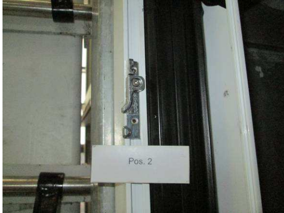
Bild 11 Verriegelungssituation Blendrahmen, Pos. 2
